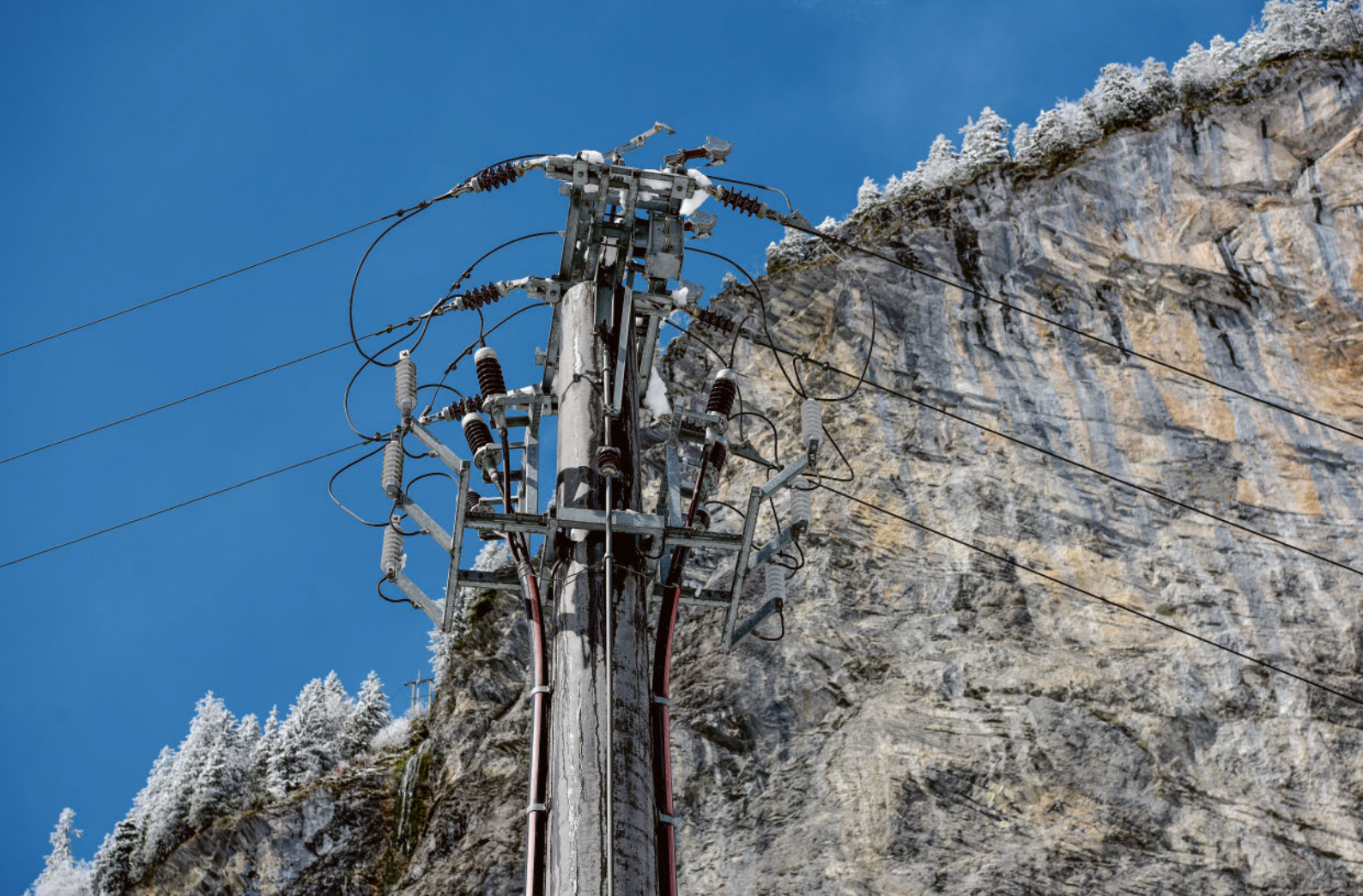
Berührt ein Vogel beim An- oder Abflug gleichzeitig zwei Strom führende Drähte, trifft ihn ein tödlicher elektrischer Schlag.
